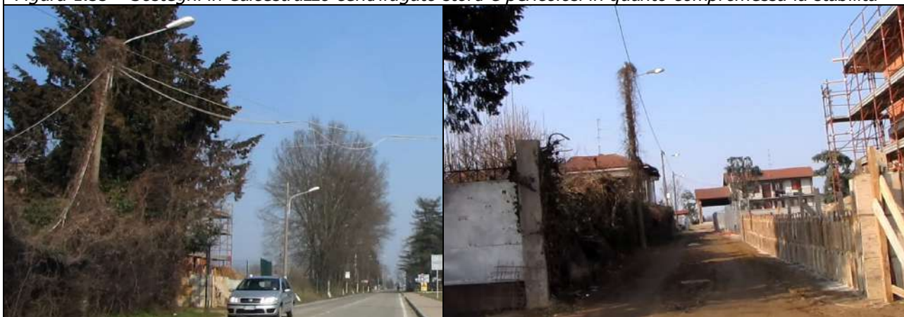
Figura 1.56 – Sostegni in condizioni pessime e ricoperti da edere e escrescenze arboree
