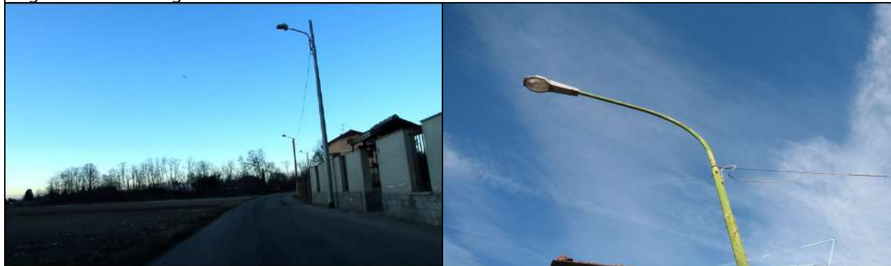
Figura 1.54 – Sostegni in acciaio zincato ottagonali adeguati per linee aeree e sostegni e sostegni in acciaio zincato da sostituire
