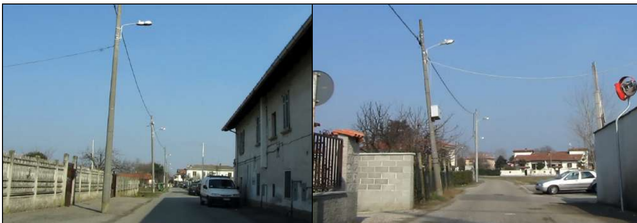
Figura 1.55 – Sostegni in Calcestruzzo centrifugato storti e pericolosi in quanto compromessa la stabilità
