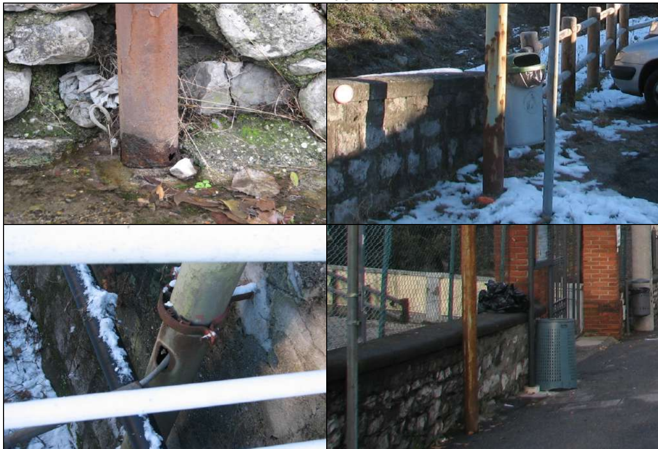
Figura 1.52 – Sostegni in acciaio verniciato da sostituire o ricondizionare
