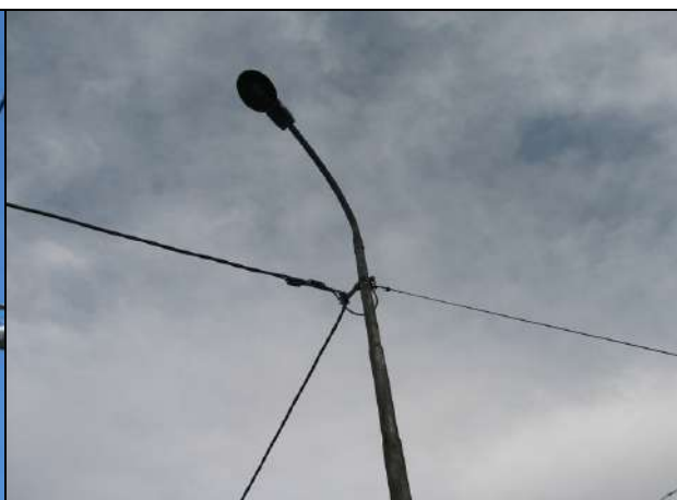
Figura 1.60 – Sostegno non idoneo per linee aeree
