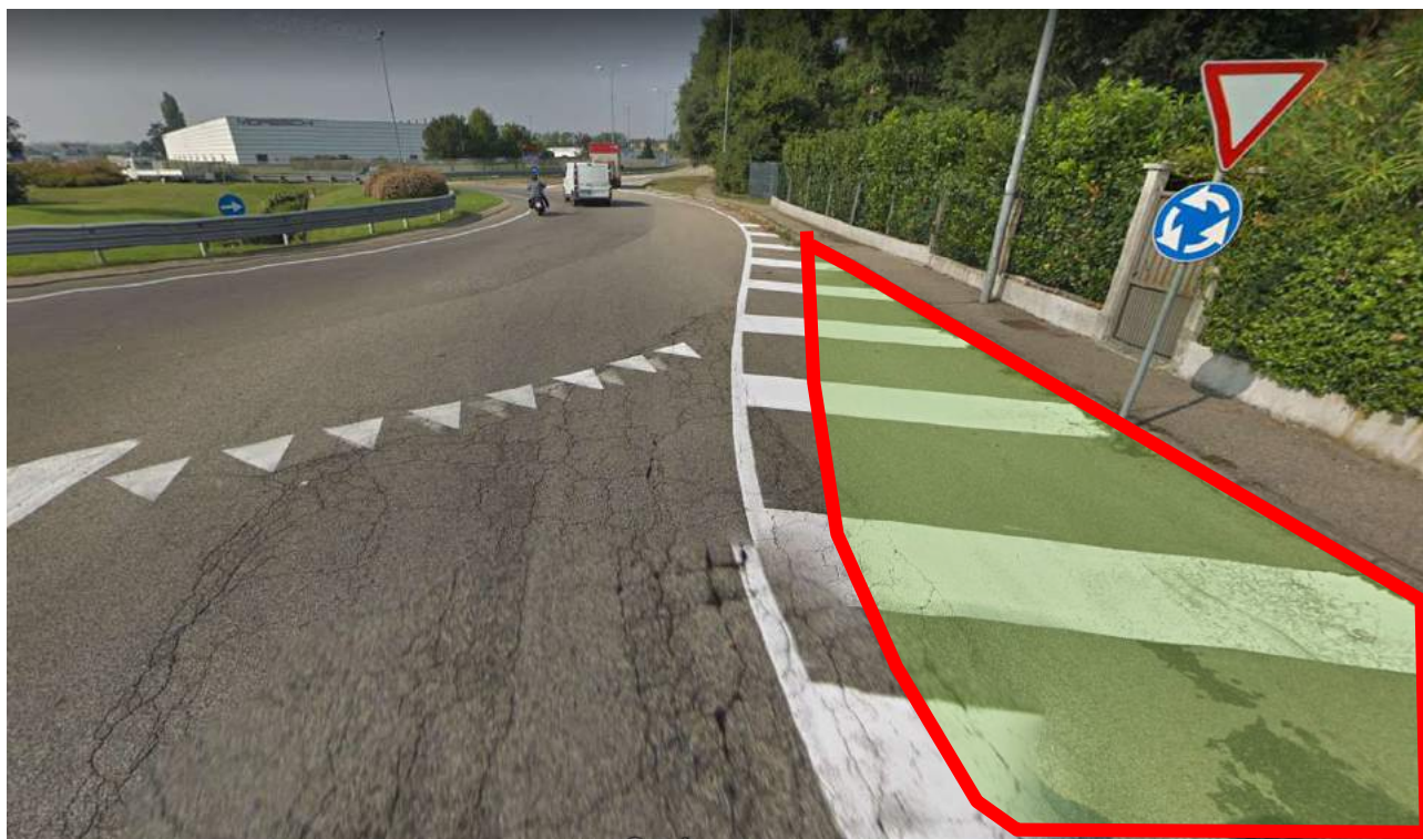
Figura 23: Realizzazione isola fisica in sostituzione della zebratura esistente
