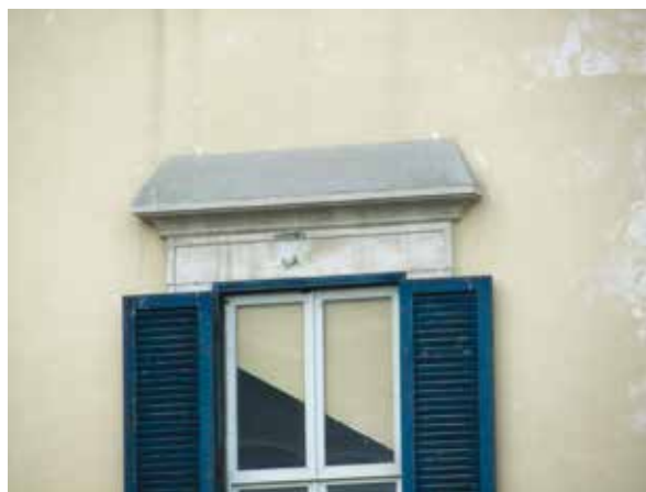
Dissuasore di appoggio a cuneo.
